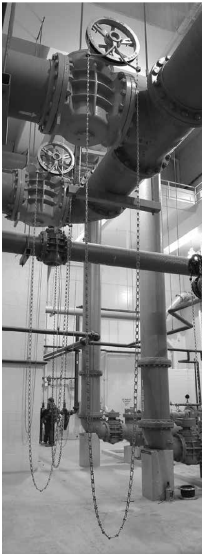
Цепь на рабочей площадке.
