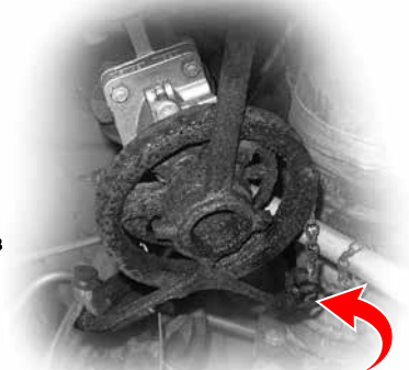
ЗАРЖАВЕВШЕЕ ЧУГУННОЕ ЦЕПНОЕ КОЛЕСО
